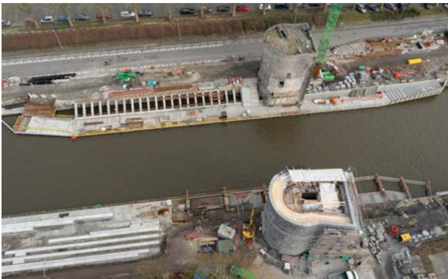
La tour du Bourdiel (tour rive gauche) directement concernée par la couverture en plomb et la tour de la Thieulerie (tour rive droite). G. Focant © SPW-AWaP
