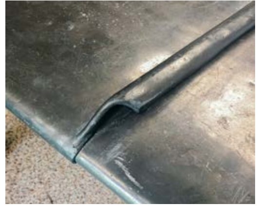
Vue en plan de l'ourlet roulé à l'interface avec le chéneau. © SPW-AW&P
