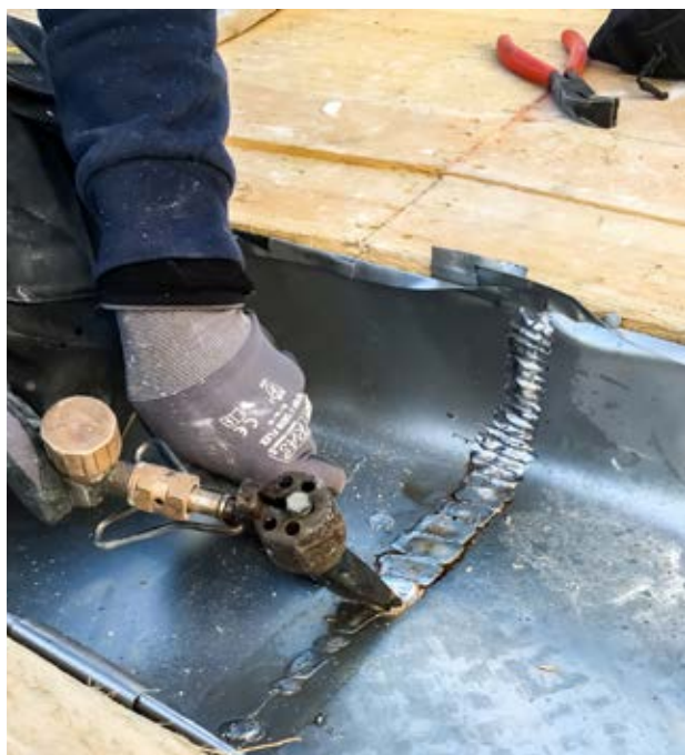
Assemblage par brasure des éléments en Inox AME formant chéneau.
