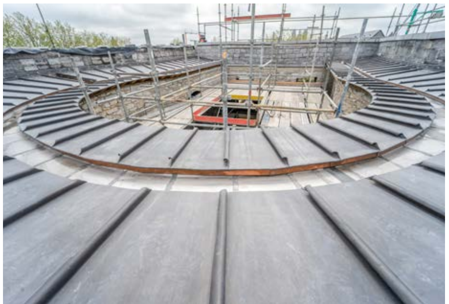
Vues d'ensemble de la couverture. © SPW-AWaP
