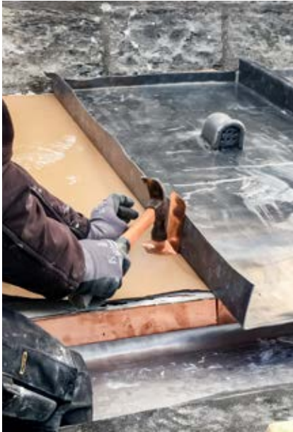
Mise en œuvre des pattes pour maintien des ourlets. © SPW-AWaP
