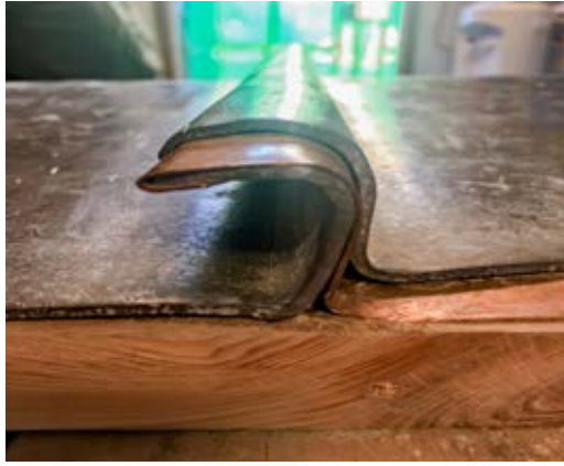
Assemblage des tables de plomb sur âme en cuivre formant ourlet. © SPW-AW&P
